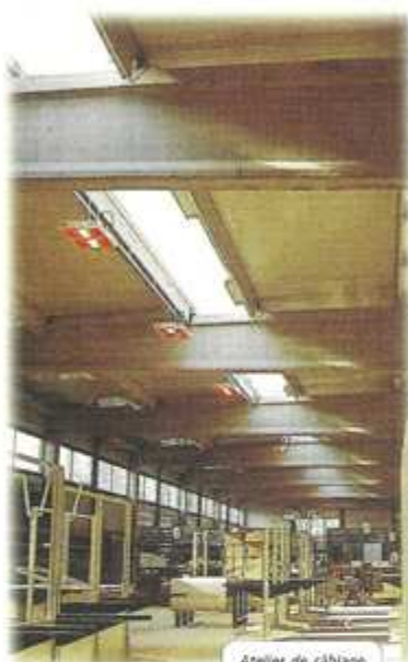
Atelier de câblage et montage.
