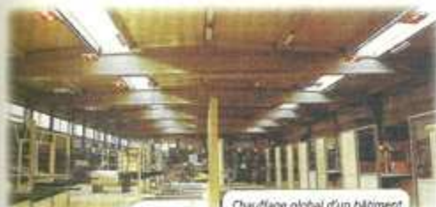
Chauffage global d'un bâtiment neuf bien isolé
