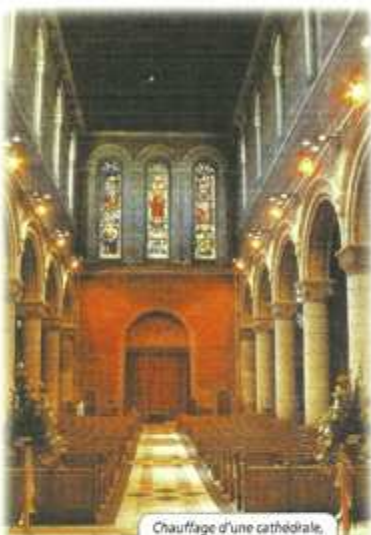
Chauffage d'une cathédrale, un bâtiment à forte inertie thermique par 20 radiants CQ135 (270 kW) implantés à 10 m du sol.
